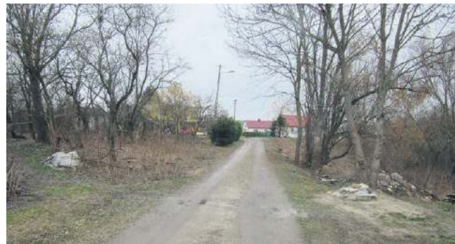
Gminna droga w Kryłowie przed modernizacją.
