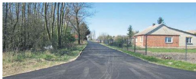
Droga w Kryłowie po modernizacji
