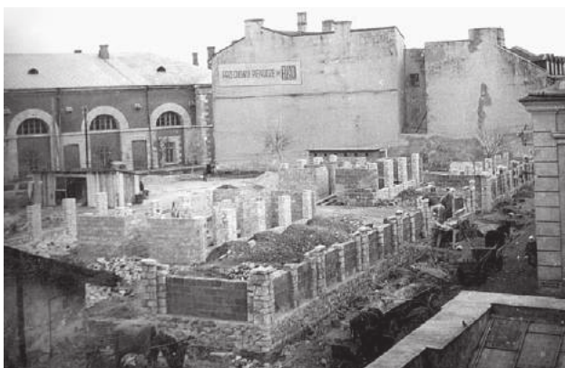
Początek lat 60. ub. wieku. Budowa tzw. zielonego rynku przy ul. Bazylińskiej i Zamenhofa. Fot. ze zbiorów APZ
