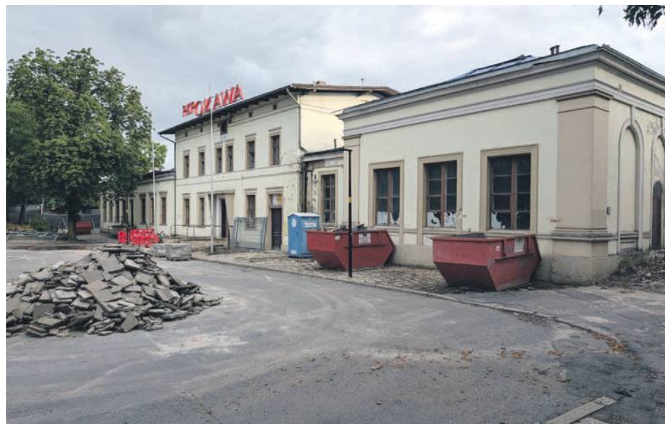
Tu już nie ma wejścia
