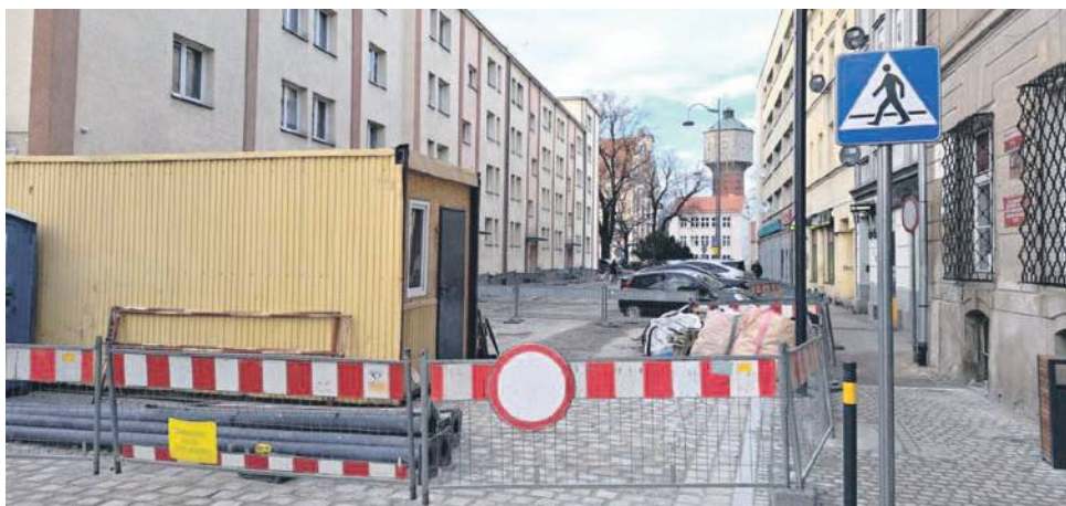
Krótka przygotowana do remontu
