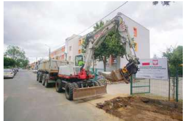
Trwają prace związane z remontem chodnika przy ul. Sienkiewicza w Strzelinie. Fot. UMiG Strzelin
