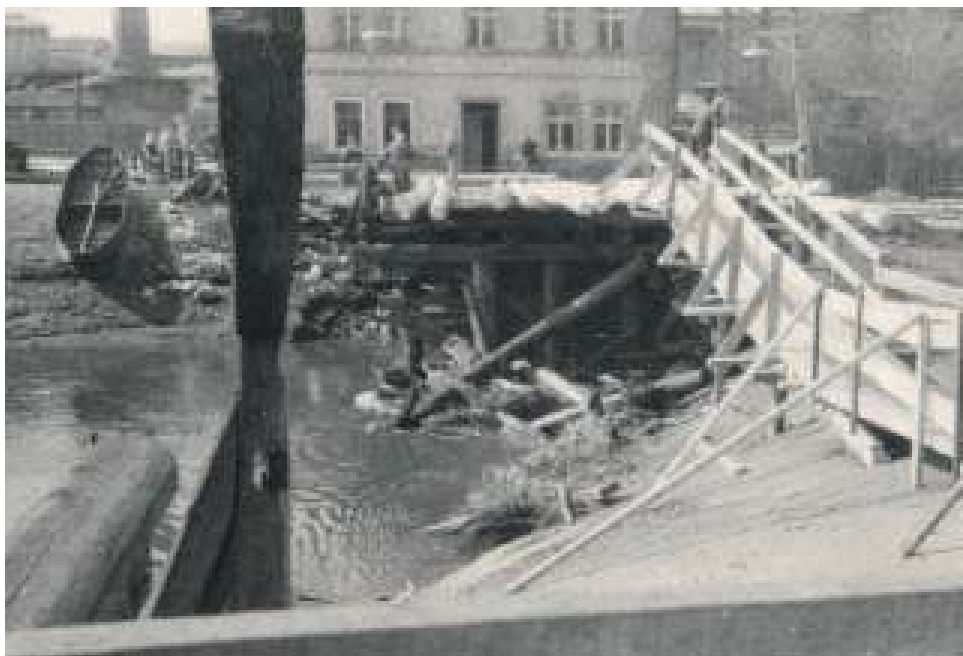
Po uszkodzeniu mostu konieczne było zorganizowanie tymczasowej przeprawy przez rzekę
