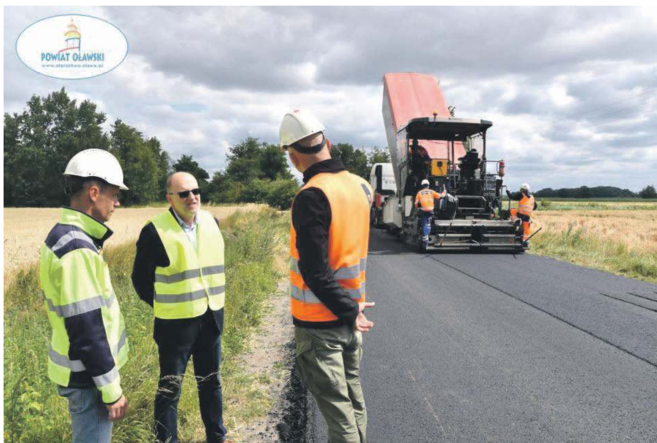
Starosta mówi, że pieniądze na remonty dróg powiatowych wciąż brakuje, ale dofinansowanie przez rząd umożliwia realizację kolejnych zadań, takich jak trwająca właśnie przebudowa odcinka Jaczkowice-Siecieborowice. Koszt wynosi 3.255.422,59 zł, zadanie w 50% finansowane jest z Funduszu Dróg Samorządowych
