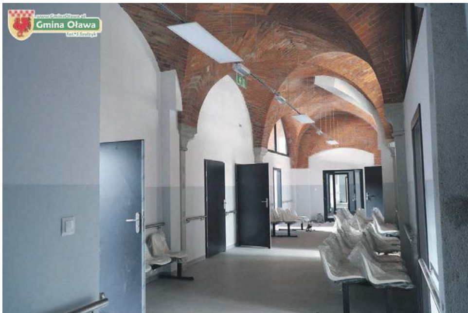
Pozostałe prace wykończeniowe
