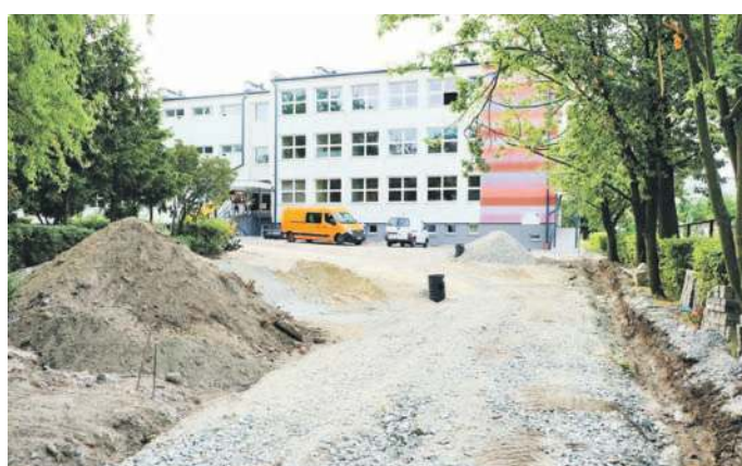
Wymiana nawierzchni przed SP nr 6
