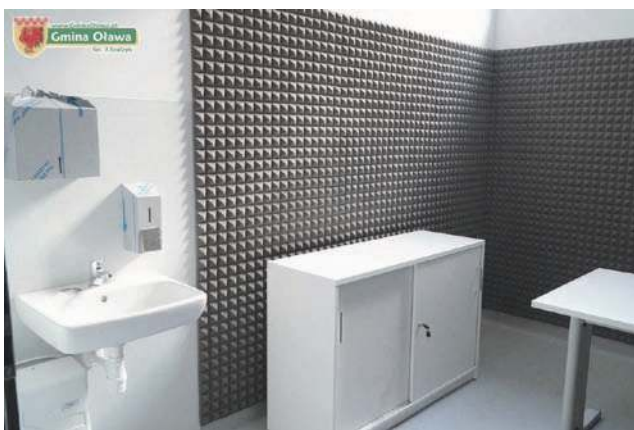
Obiekt niebawem zostanie odebrany
