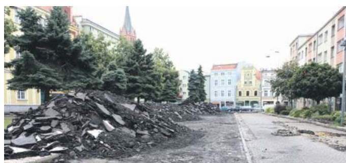
W ramach rewitalizacji Rynku, rozpoczęły się prace na północnej pierzei
