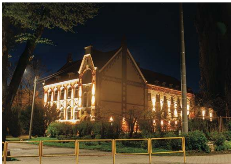
Inwestycja na ulicy Lipowej
