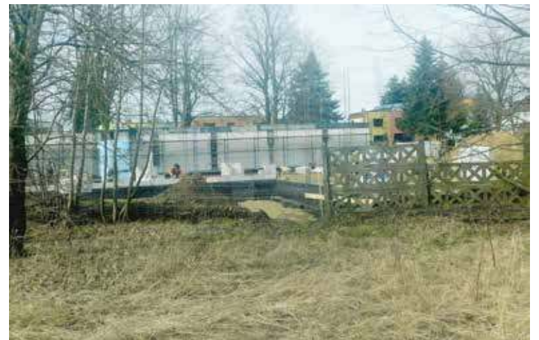
Trwają prace budowlane nad pawilonem z przeznaczeniem na handel
