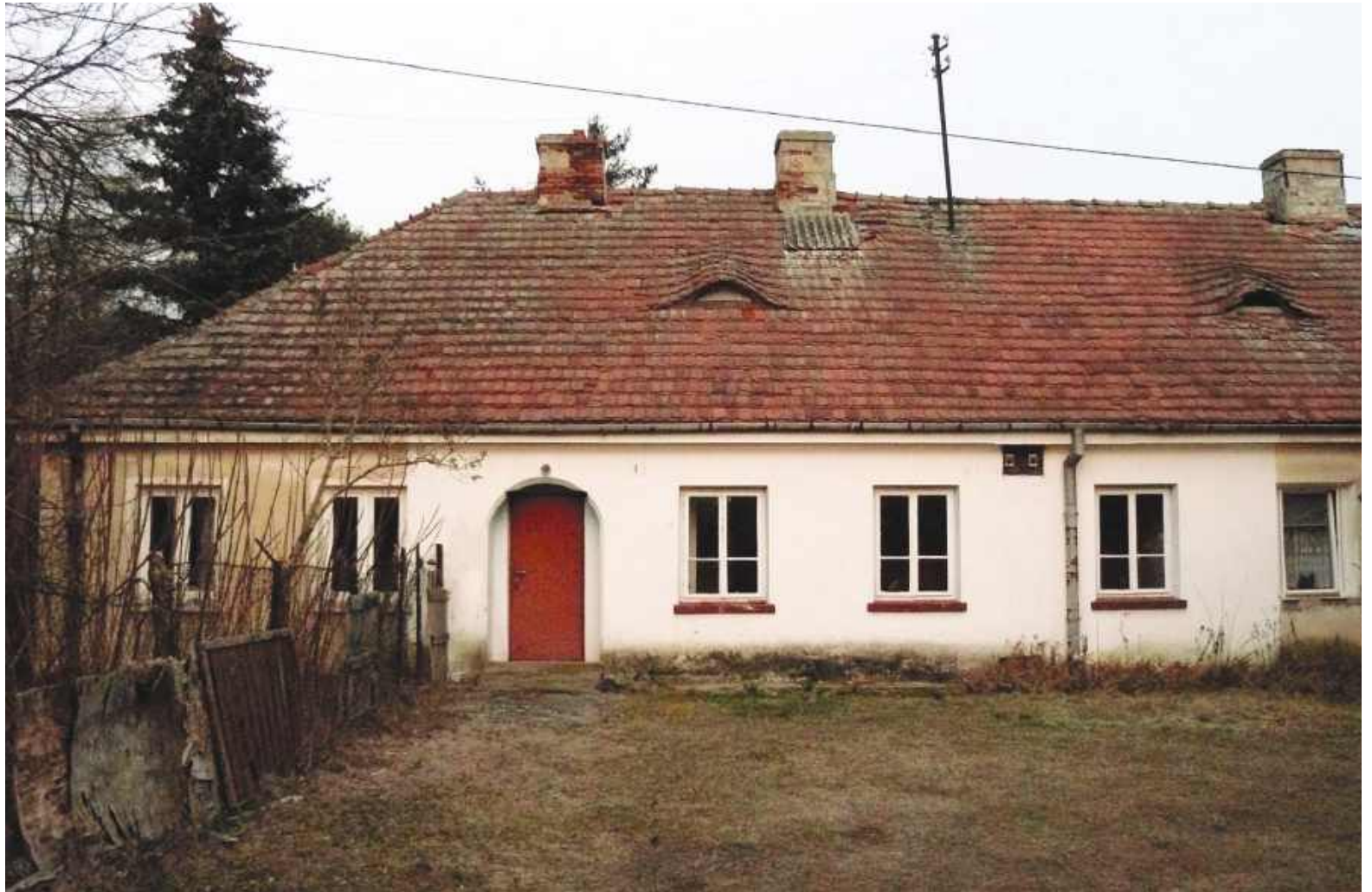
Zabytkowa oficyna przy ruinach pałacu
