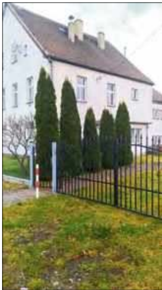
Budynek byłego przedszkola nr 4 w Zdzeszowicach od kilku lat czeka na nowego właściciela.
