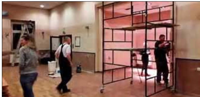
Prace przebiegały szybko i sprawnie.
