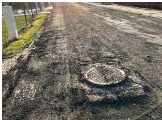
Trwa ostatni etap prac, czyli naprawa drogi.
