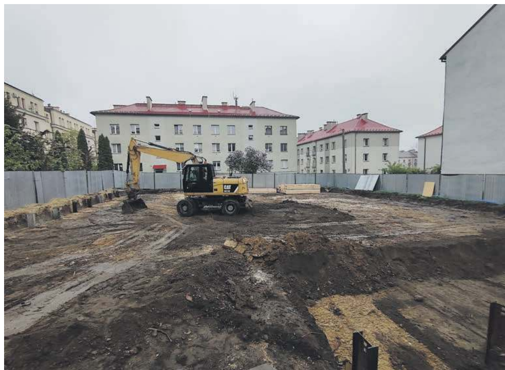
Budowa budynku mieszkalnego przy al. Henryka w Chrzanowie
