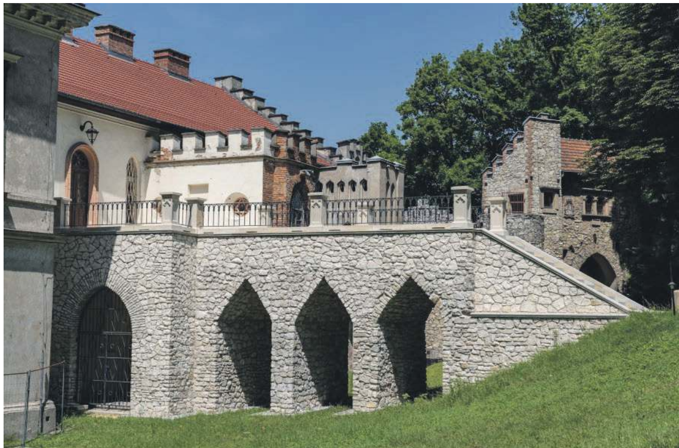
Most nad suchą fosą przebudowany. Fot. Łukasz Gluch, 2023
