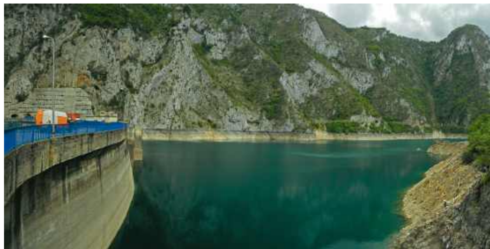
Mratinje to druga co do wysokości tama w Europie. Spad zasila hydroelektrownie o mocy 342 MW.
