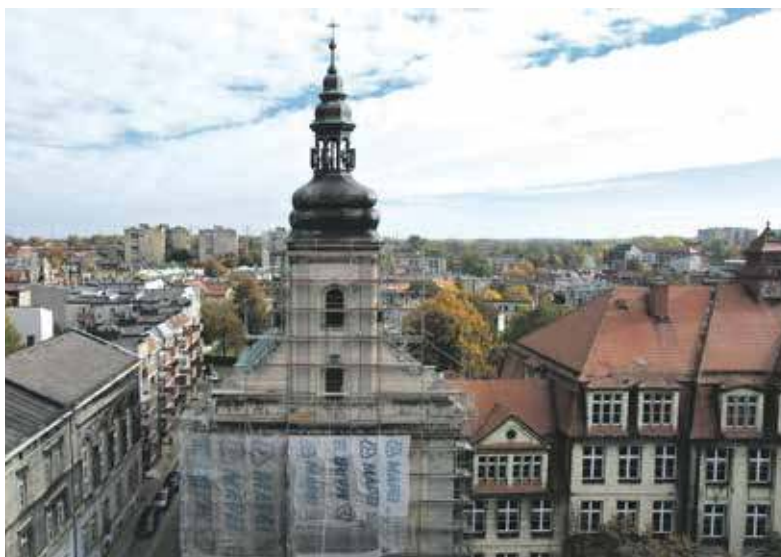
Wokół wieży ustawiono rusztowania
