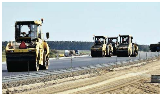
Budowa drogi S5 Ostróda — Nowe Marzy
