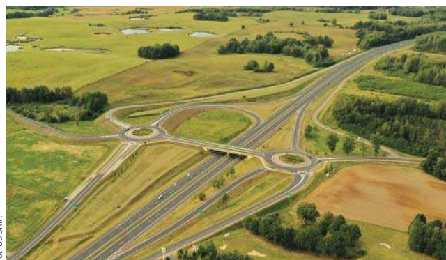
Budowa drogi S16 Mrągowo — Orzysz — Ełk
