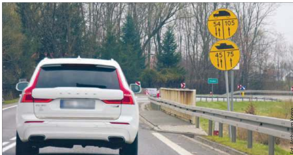
Most w Zarębkach na drodze krajowej nr 9 zostanie wyremontowany.
