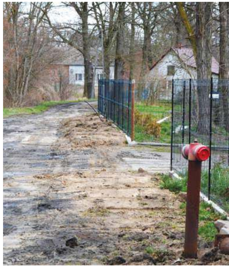
W Studzieńcu trwają prace przy budowie oświetlenia
