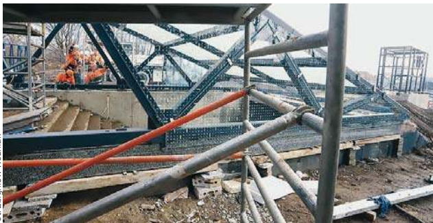
Udostępnienie przejścia oraz zakończenie przebudowy stacji Olsztyn Główny zaplanowane jest w maju
