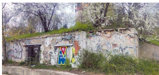
Pozostałości starej lodowni przy ulicy Północnej
