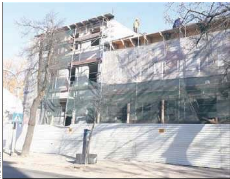
W budowanej właśnie kamienicy przy ul. Sienkiewicza 40 i 42 znajdują się kolejne „Mieszkania na start”
