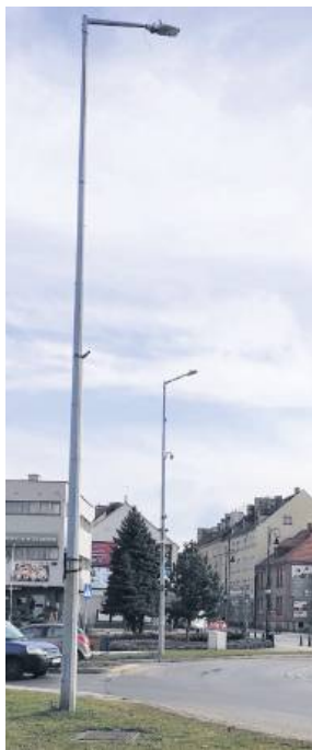
Po kilku dniach od zamontowania nowych opraw na strzebińskim rondzie zwiększono ich moc
