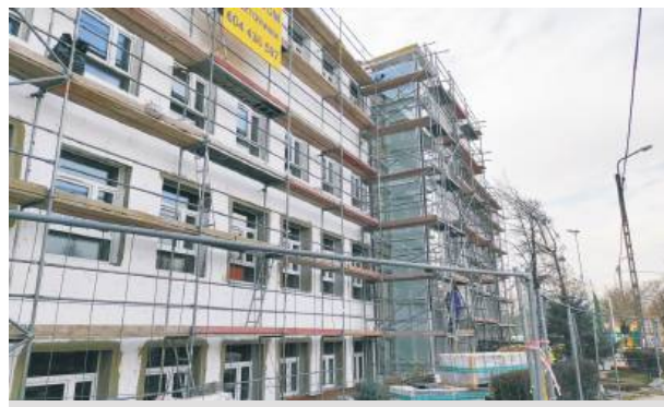
W Szkole Podstawowej nr 4 w Strzelinie trwa obecnie montaż zewnętrznej windy
