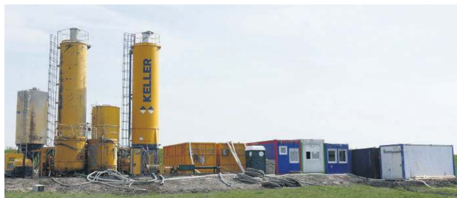
Nad zbiornikiem zalewowym postawione są urządzenia do produkcji mieszanki uszczelniającej i silosy do jej magazynowania
