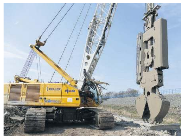
Na miejscu pracuje wążca ponad 100 ton głębiarka z chwytakiem
