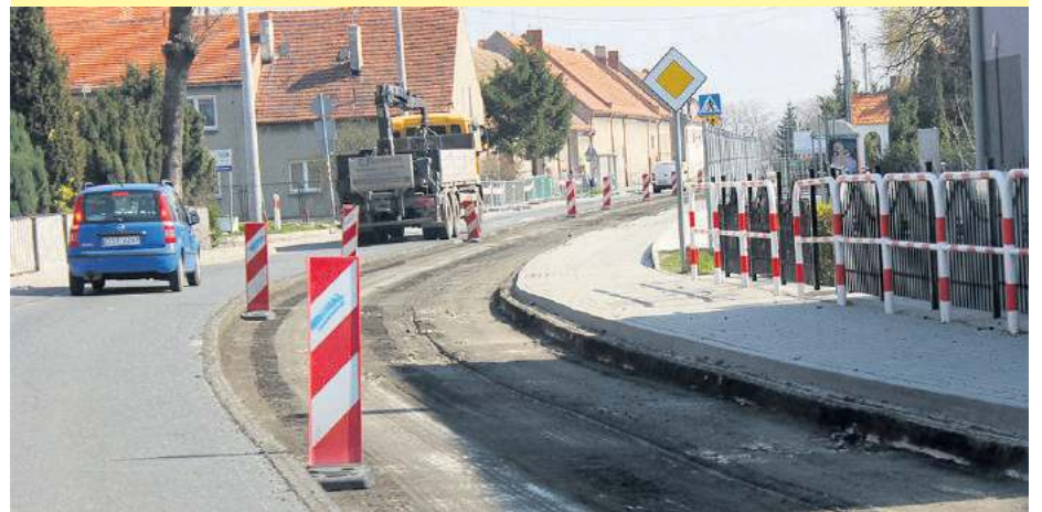
Obecnie ruch odbywa się wahadłowo, z zastosowaniem sygnalizacji świetlnej
