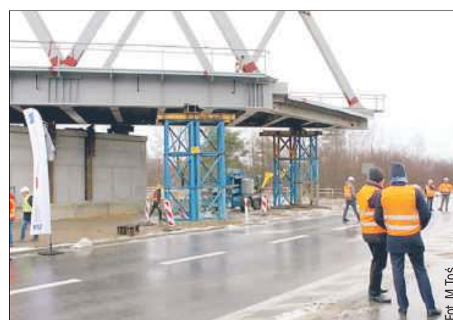
Wiadukt powstaje nad DK9.
