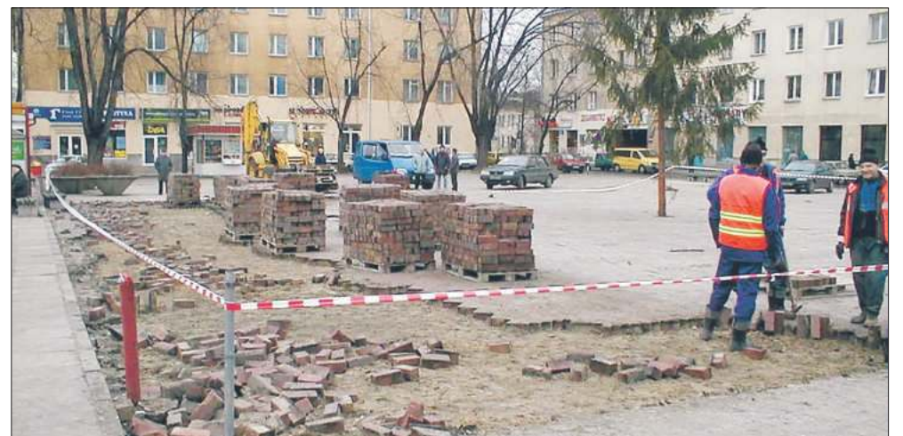
Plac AK w remoncie.
