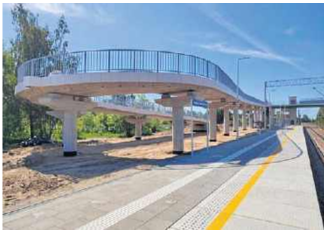
Trwają prace przy budowie kładki dla pieszych i przystanku kolejowego Radom Południowy.
