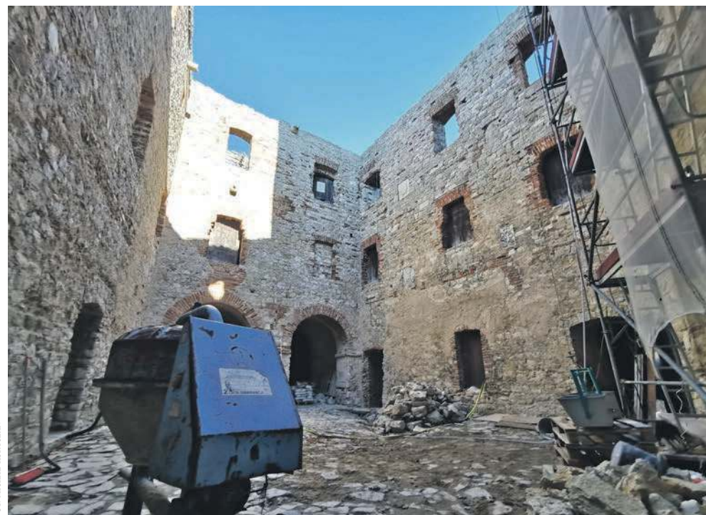
Prace konserwatorskie objęły m.in. dziedziniec zamkowy
