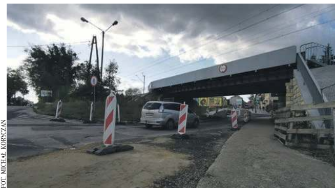
Wiadukt nad ul. Krakowską w Chrzanowie
