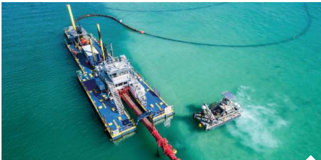
Prace przy Baltic Pipe przebiegają zgodnie z harmonogramem. Gazociąg ma być uruchomiony na początku października | fot. mat. pras./d
