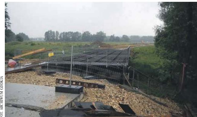
Trwa budowa nowej drogi
