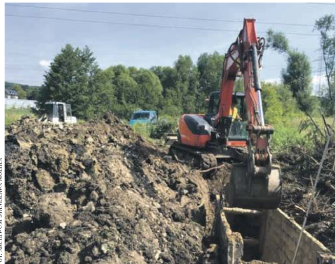
Rozpoczęła się budowa kanalizacji w Siedlecu
