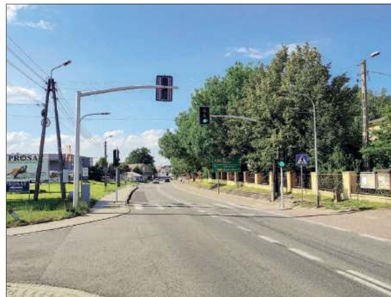
■ – Budowa chodników, ciągów pieszo-rowerowych i sygnalizacji świetlnej to jedno z najskuteczniejszych i najbardziej efektywnych rozwiązań z zakresu inżynierii drogowej – przekazuje GDDKiA FOT. GDDKiA
