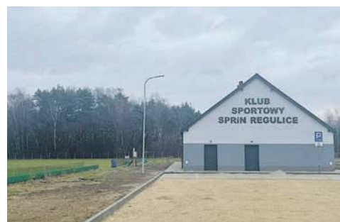
Nowy budynek przy boisku piłkarskim w Regulicach
