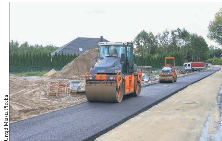
Trwa przebudowa ulicy Browarnej
