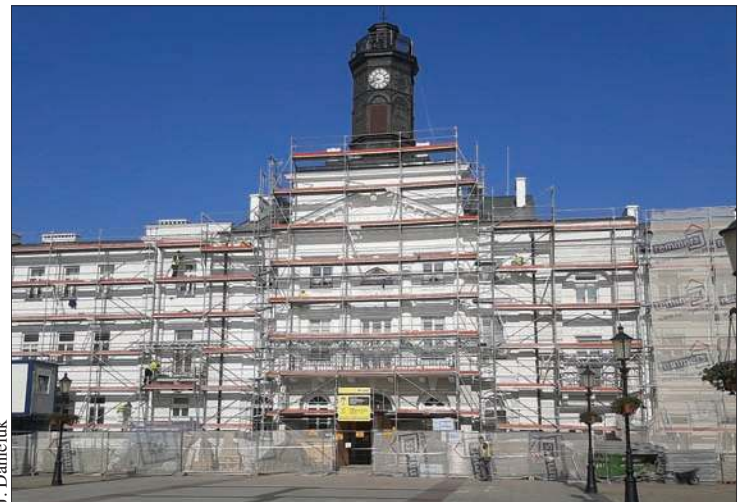
Prace przy remoncie elewacji płockiego ratusza potrwać jeszcze dwa miesiące
