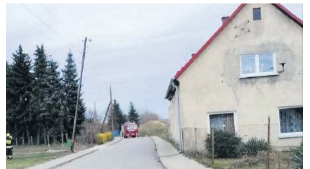
Strażacy zabezpieczali zerwaną linię energetyczną (Foto: Strzelin998)
