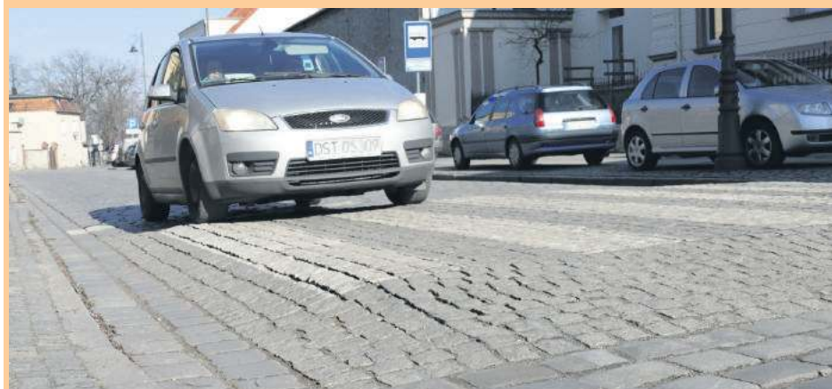
Przy Liceum Ogólnokształcącym w Strzelinie wybudowano wyniesione przejście dla pieszych. W mieście jeszcze w tym roku powstaną dwa takie przejścia
