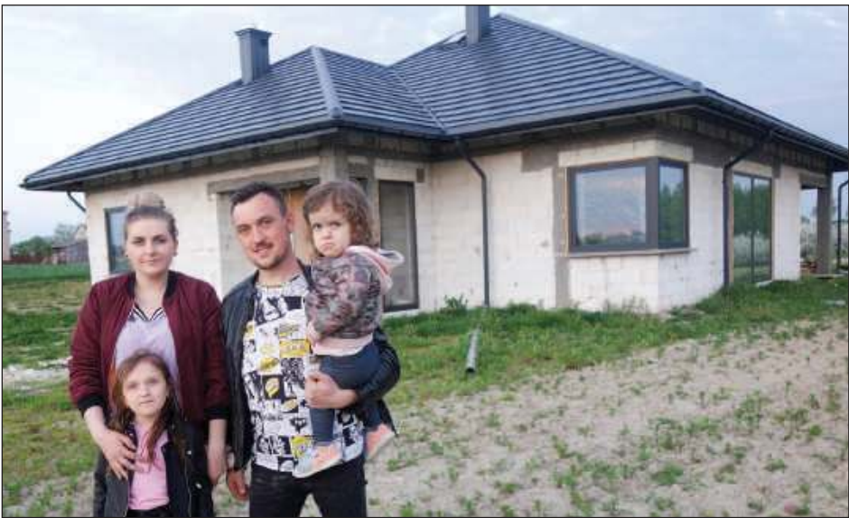
✚ - Rozpoczęliśmy budowę 4 lata temu. Dobrze, że mamy już dach, bo stal zdrożała od tamtej pory o 100%, więc musielibyśmy zapłacić o wiele więcej za pokrycie - mówi pani Olga. Na zdjęciu z mężem Grzegorzem i córkami Zuzią i Amelką
