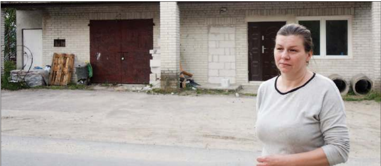
Małgorzata Mich. przyznaje, że świetlica środowiskowa jest potrzebna. - Trzeba wyremontować budynek, żebyśmy mogli zacząć tu działać - mówi
