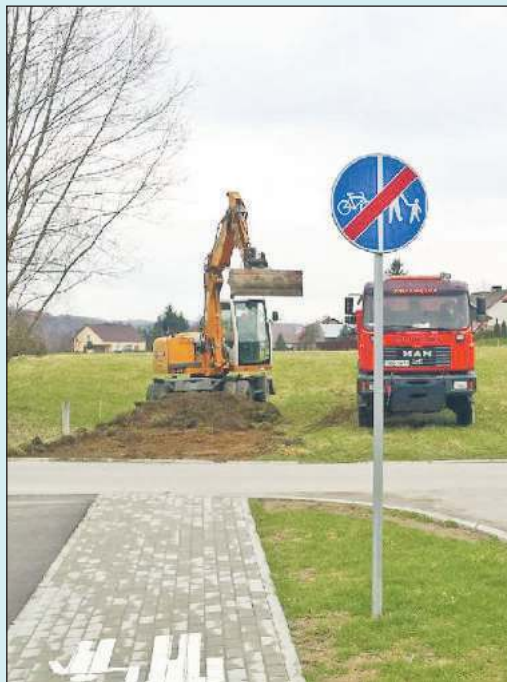
Rozpoczęły się prace przy budowie drugiej części łącznika w Brzostku.
