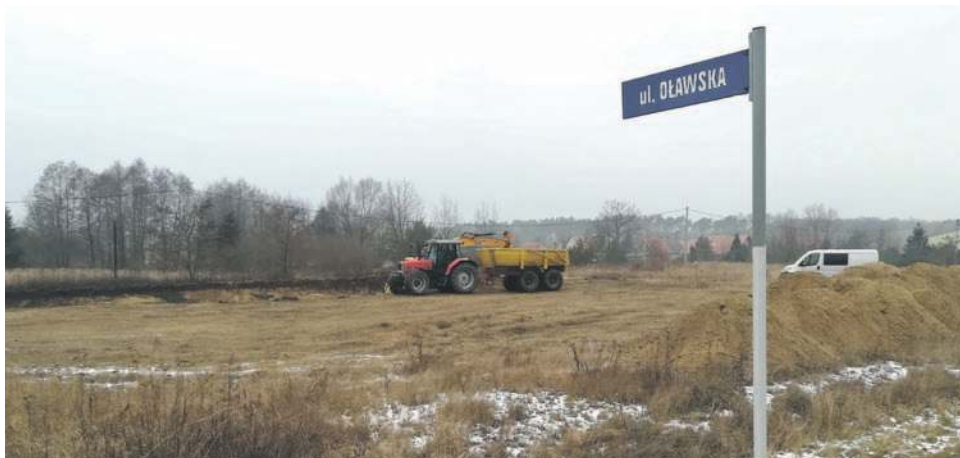
Supermarket Dino powstaje w Janikowie przy ul. Oławskiej, niedaleko centrum wsi
