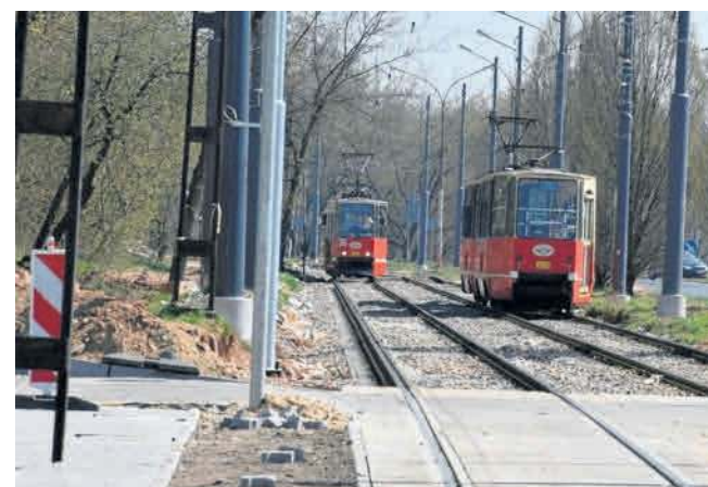
Dąbrowa Górnicza: trwa remont torowiska tramwajowego w Gołonogu
