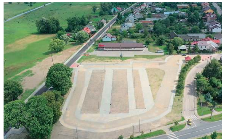
Nowo wybudowany plac targowy za niemal 2 mln zł oraz ulica Leśna za kwotę 5,5 mln zł
