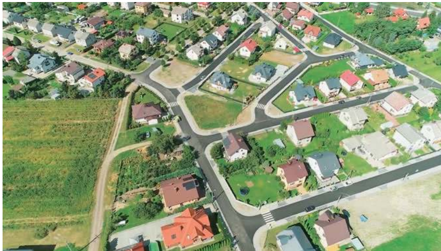
Rozbudowane drogi gminne na osiedlu w Bieżuniu na kwotę niemal 5 mln zł
