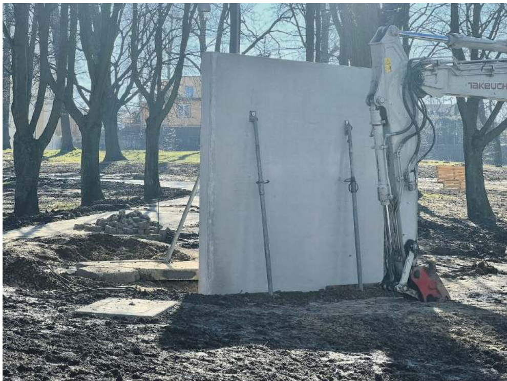
Jest też betonowa ściana
