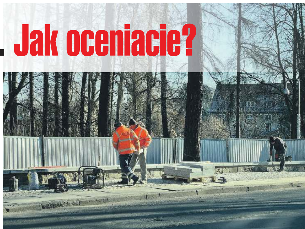
Układają na murku płyty
