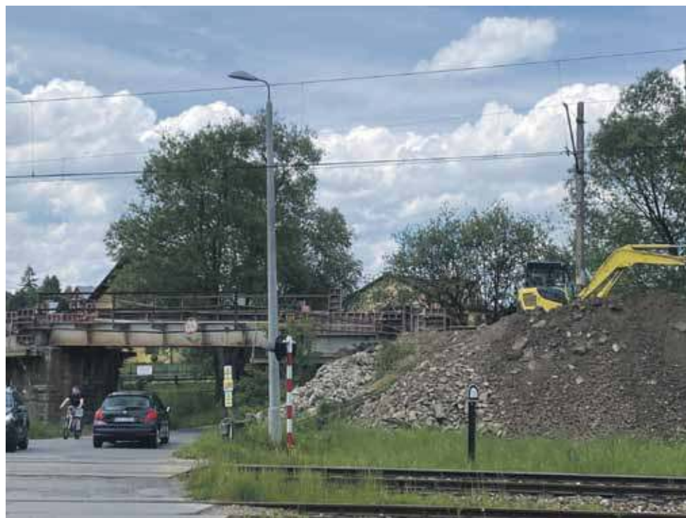
Remontowany wiadukt na linii kolejowej Kraków - Chabówka.
