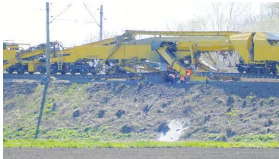
Remont torowiska pozwoli pociągom na jazdę z prędkością 100 km/h
