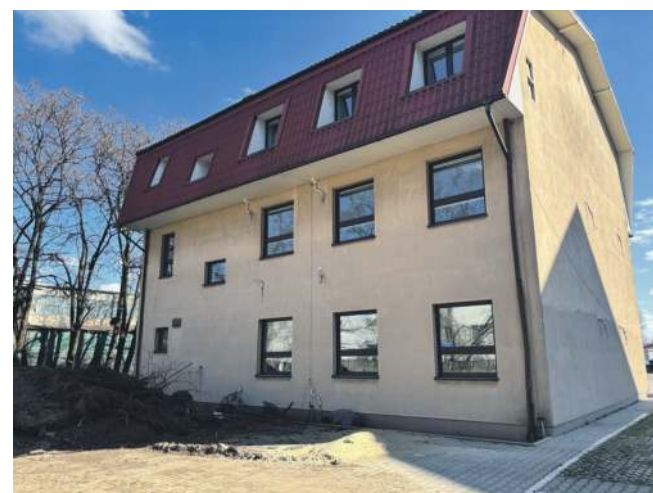
Budynek, w którym powstaje szkoła
