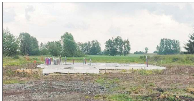
Wielu inwestorów zostało z samą płytą fundamentową
