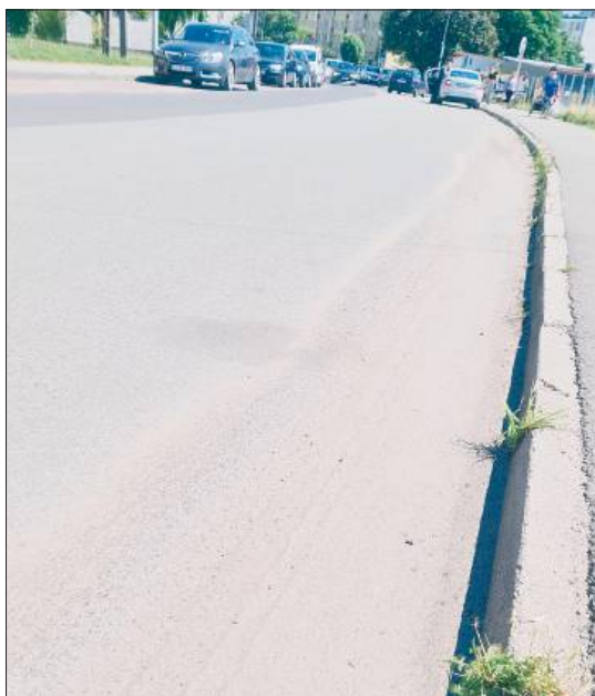
Ulica Budowlana – 8 lipca.
