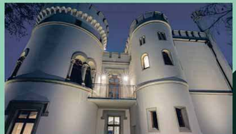
Po pałacu w Miechowicach pozostała jedynie oficyna
