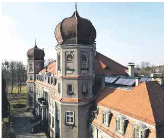
Budowlę zdobią dwie wieże nakryte hełmami
