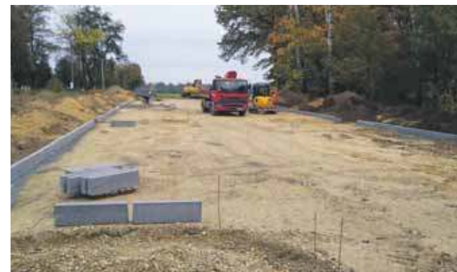
Na budowie parkingu na razie się skończyło
