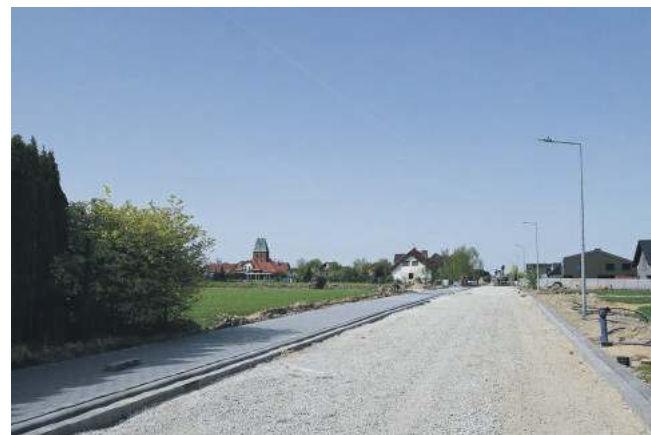
Przebudowa ulicy Wiosennej w Krynicznie
