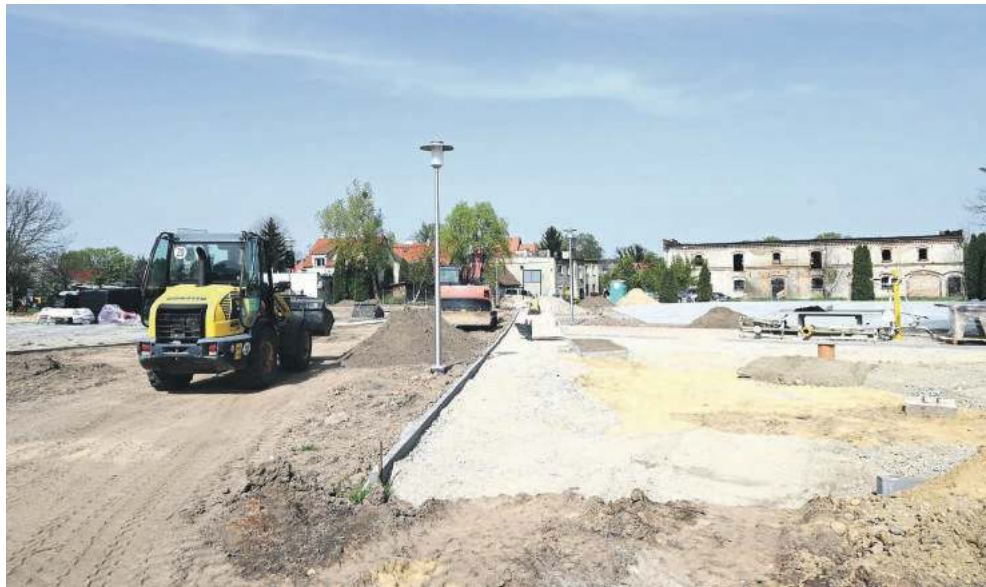
Trwa budowa skate parku w Strzeszowie
