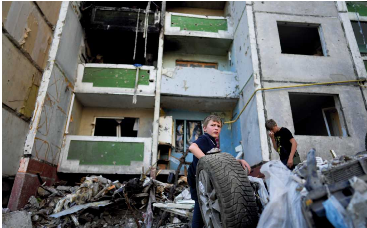
• Zniszczony budynek mieszkalny w Czernihowie, 19 czerwca 2022 r.
