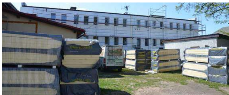
Prace prowadzone są także na tyłach kompleksu.
