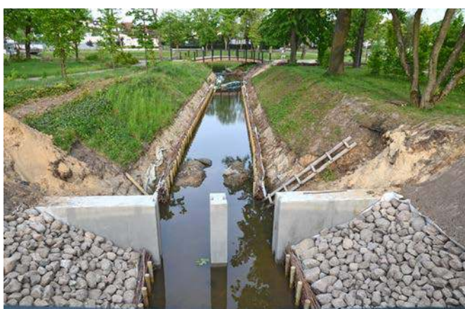
Budowa zasuw prowadzona jest równolegle na dwóch kanałach.
