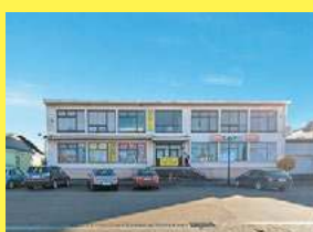
Dom handlowy w samym centrum Janowa Podlaskiego, 885 851 161
