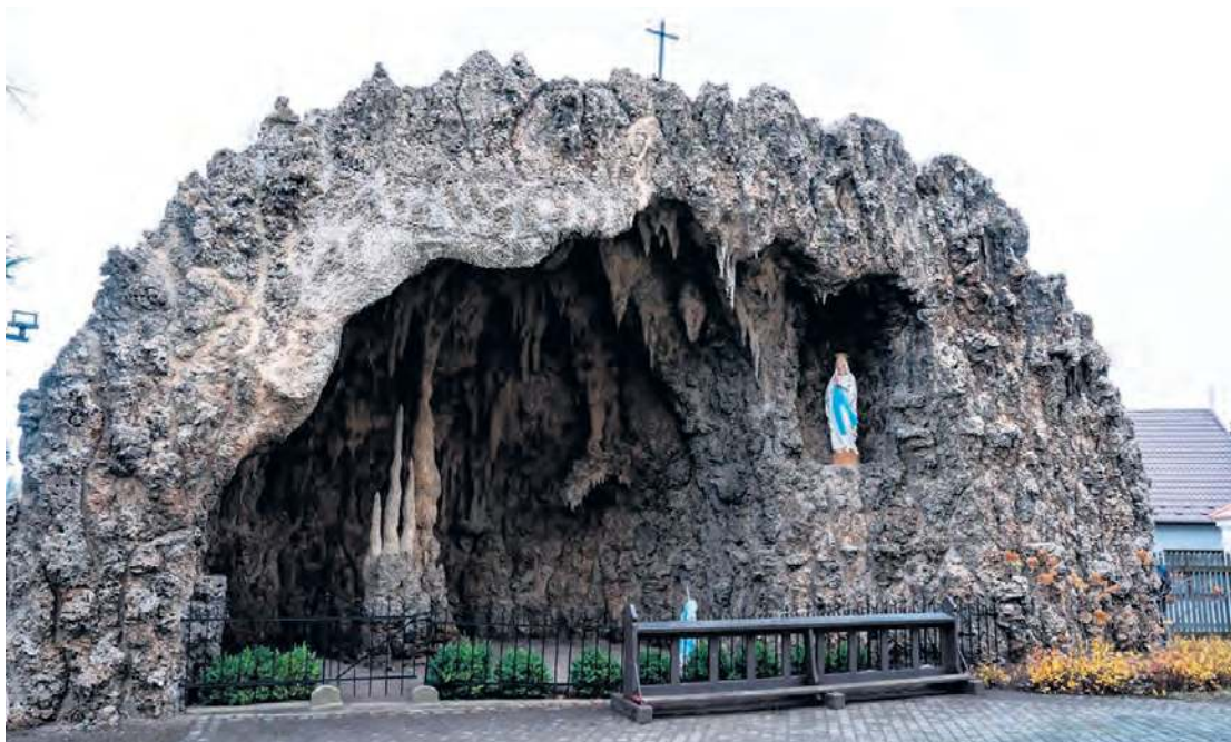
Grota Najświętszej Marii Panny z Lourdes w Śliwicach została wybudowana w pierwszej dekadzie XX wieku. Fot. Gmina Śliwice
