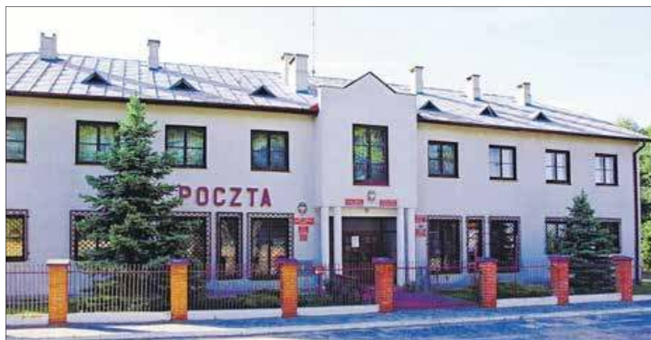
Remont przeszedł również budynek urzędu gminy, w którym mieści się Poczta Polska i biblioteka
