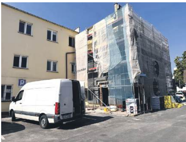
Trwa remont biurowca
