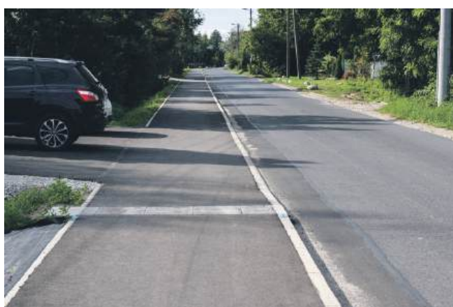
Tak wygląda wyremontowany fragment ul. Chrobrego
