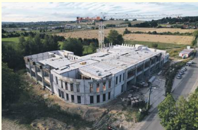
Obecnie trwa murowanie ścian piętra
